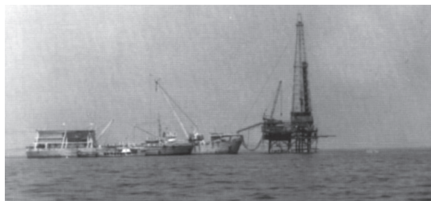
Figura 9. La scoperta del gas naturale nel Mare Adriatico ("Ravenna Mare", 1960). Questo campo fu il primo giacimento di gas offshore scoperto nell'Europa occidentale, ed entrò in produzione nel 1964.
