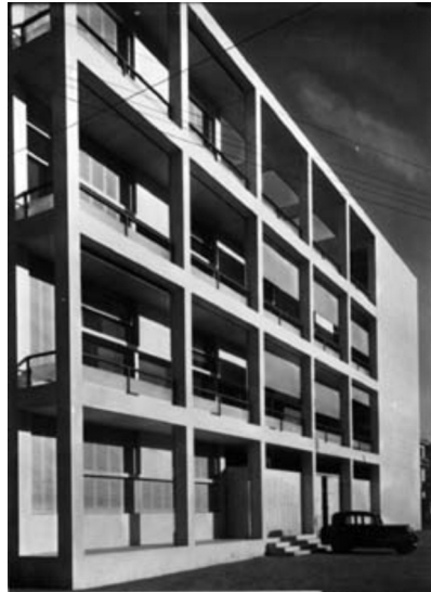
COMO: Casa del Fascio (G. Terragni, 1936)
