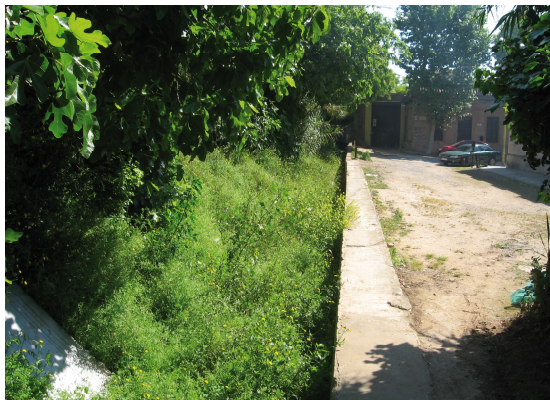
d Canal al pont de Conflent (Font Morata)
