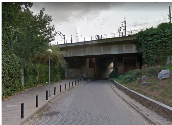
d Pas sota tren al cementiri (Font Google Maps)
