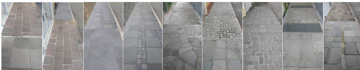
Fig. 16. Percurso 2 - Piso média heterogeneidade – variação de um mesmo tipo de piso (pedra basalto), porém com diferentes tamanhos e disposições, ao longo de uma mesma quadra (cenas dispostas na ordem em que apareceram no vídeo). Fonte: Knapp, 2018
