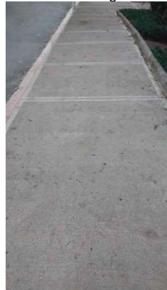
Fig. 8. Vista F Concreto moldado in-loco
