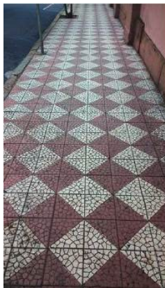
Fig. 12. Vista J Ladrilho hidráulico, losango vermelho e branco
