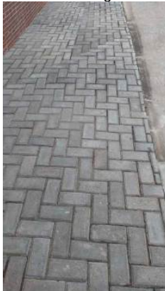
Fig. 7. Vista E Concreto intertravado
