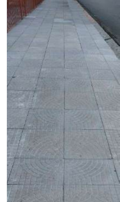
Fig. 6. Vista D Placa de concreto estampada
