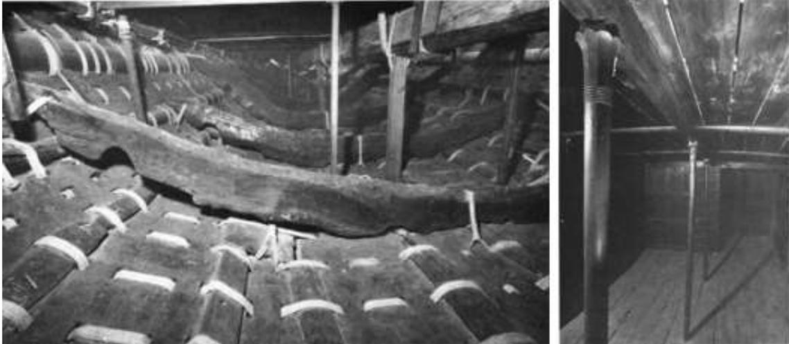
**Figura 19.** Estructura interior del casco y vista del interior de la cabina principal de la barca de Keops
