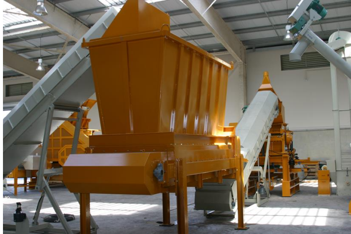
Imagen 5.2.1.1.1. Tolva de alimentación de residuos sólidos.
