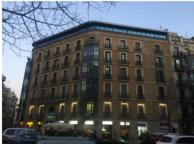
Fig.3.1. Fotografia de l'edifici d'estudi des del carrer Aragó. Font: Carolina Porta
