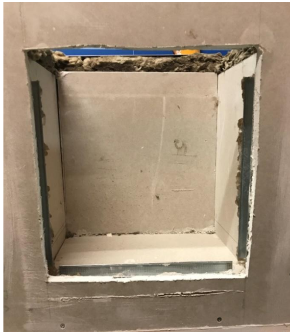
Figura 74: Vista frontal del marc retallat per instal·lar la planxa metàl·lica. Font: Pròpia
