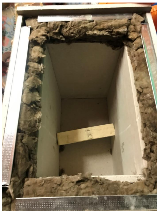
Figura 72: Vista de l'estructura acabada des de la cara que es pot obrir. Font: Pròpia
