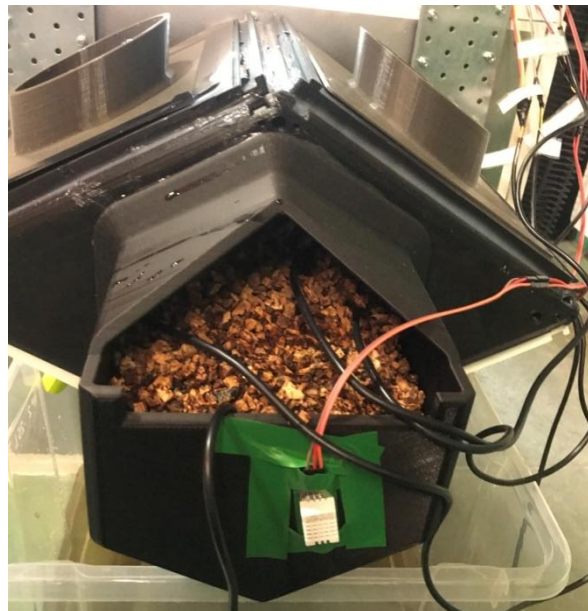
Figura 81: Vista frontal dels sensors instal·lats. Font: Pròpia
