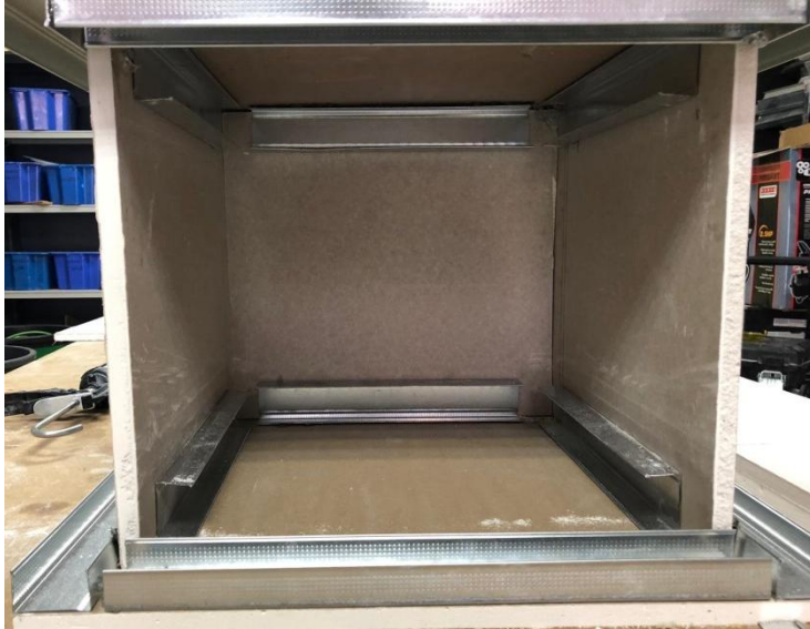
Figura 69: muntatge de l'estructura i les parets interiors. Font: Pròpia
