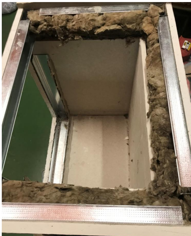
Figura 75: Vista lateral del marc retallat per instal·lar la planxa metàl·lica. Font: Pròpia
