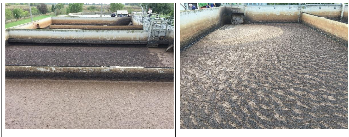
Ábra 2.2: Biológiai fokozat N- és DN-zónákkal, Karcag
