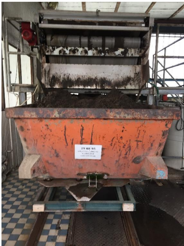
Ábra 2.3: Szalagszűrő prés szállítókonténerrel, Karcag
