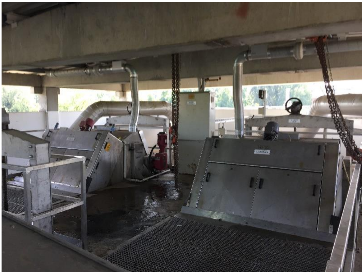
Ábra 2.2: Finomszűrő berendezés MEVA ráccsal, Debrecen
