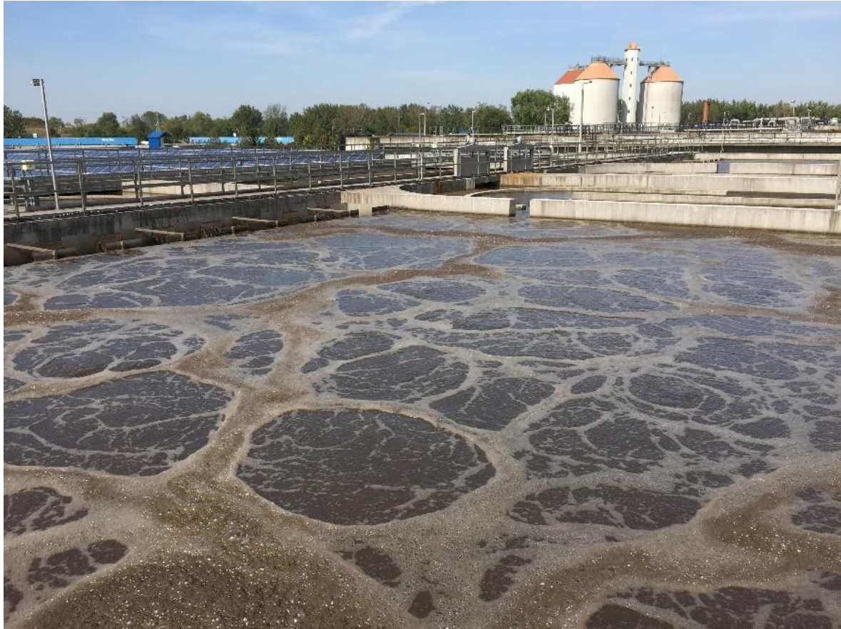
Ábra 2.3: Mélylégbefúvós biológiai medence, Debrecen
