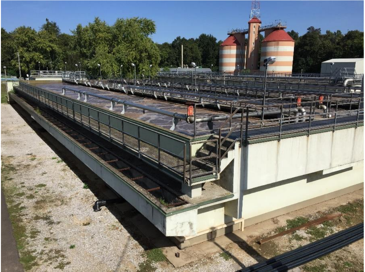
Ábra 7.2: Biológiai fokozat (a háttérben a rothasztó berendezés), Nyíregyháza
