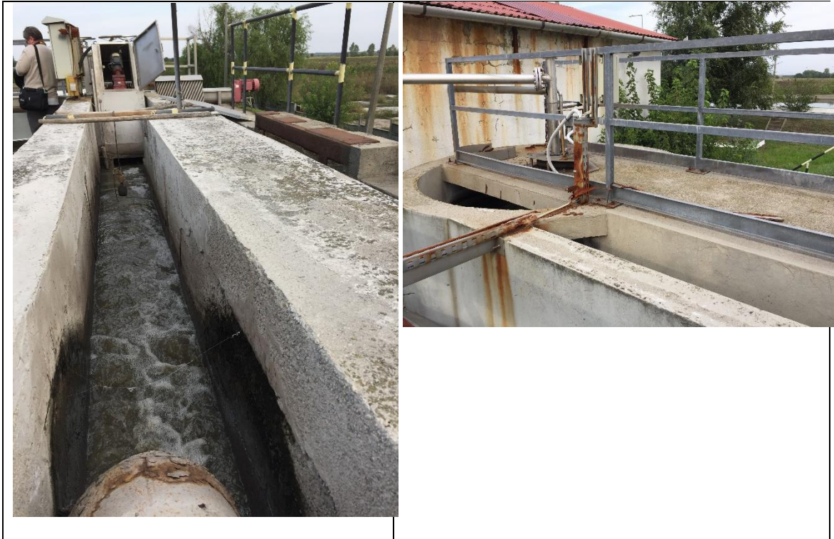
Ábra 2.1: Szűrőberendezés és levegőztetett körformájú homokfogó, Karcag
