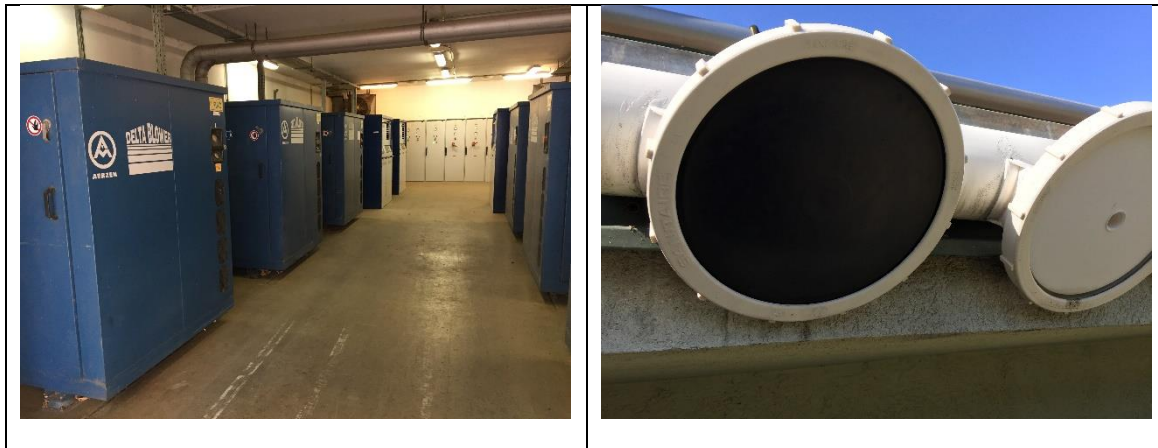
Ábra 7.3: Fúvóberendezés és tányéros diffúzorok, Nyíregyháza
