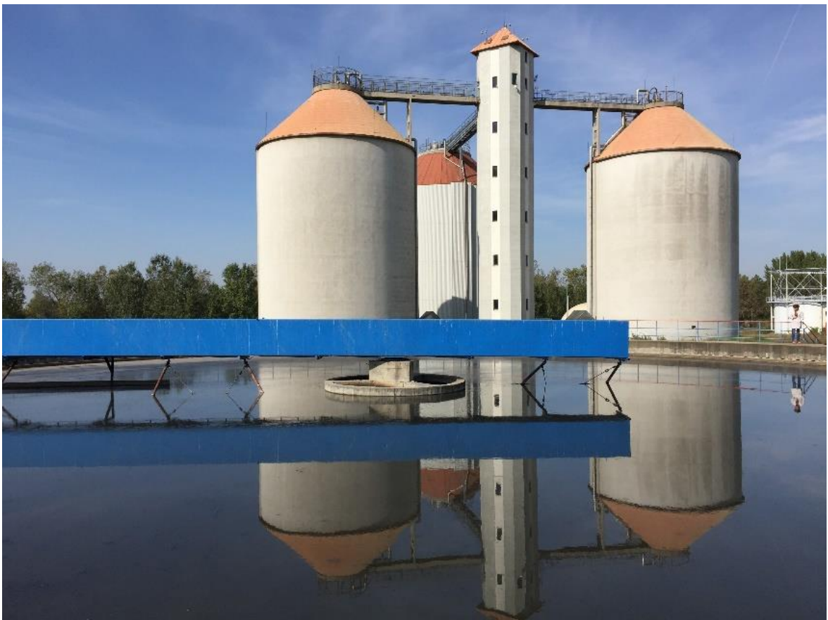
Ábra 2.4: Rothasztó tornyok , Debrecen
