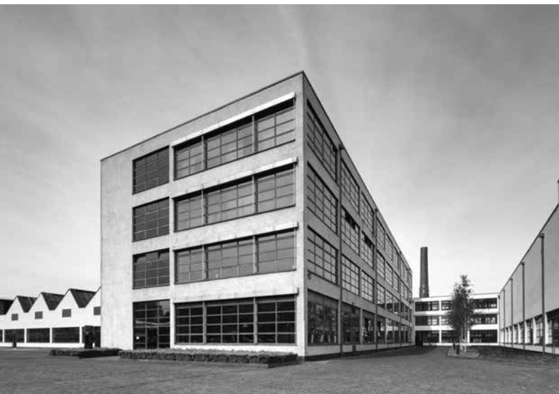
Das HE-Gebäude der Verscheidag-Fabrik. HE steht für Herrenfutterstoffe. Links daneben sind die Shedhallen zu sehen. Foto: Nina Kuka und Chelina Schütz/TH Köln.
