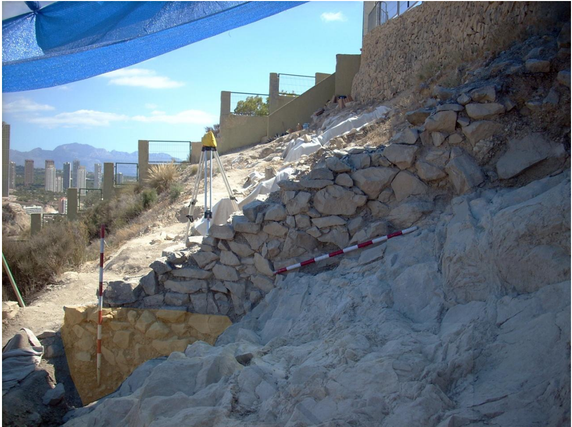
Figura 101. Detalle de zapatas de cimentación
