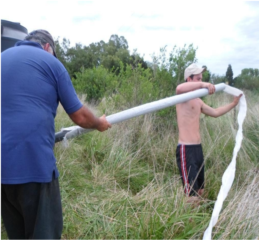
Figura III.a. Enfundado del caño con malla plástica.
