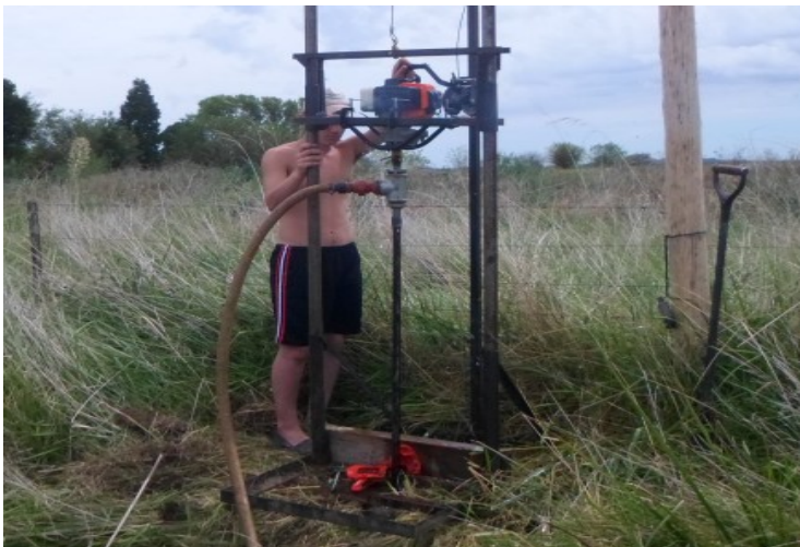
Figura III.b. Hoyadora utilizada para la perforación
