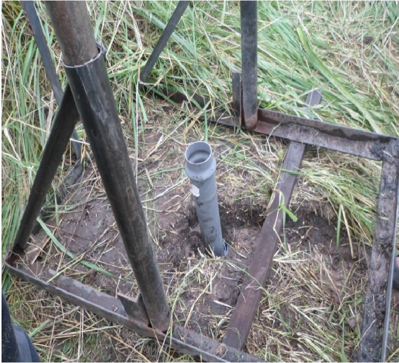
Figura III.c. Caño de PVC colocado en pozo
