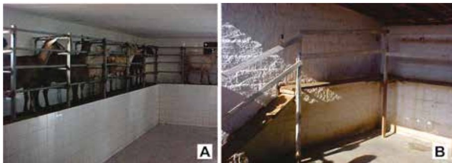
Figura 2. Exemplos de salas de ordenha: com azulejo e ferro galvanizado (A) e com reboco e plataforma de madeira (B).
