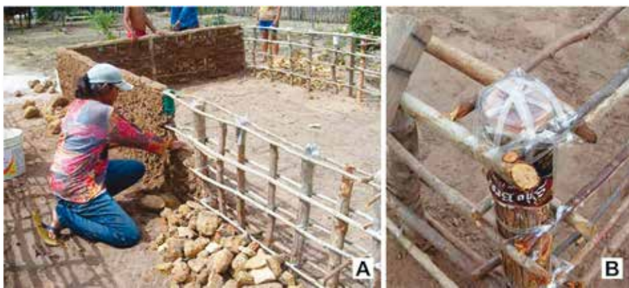
Figura 13. Tanques retangulares de taipa (A) e detalhe das amarrações feitas com tiras de garrafa PET (B).
