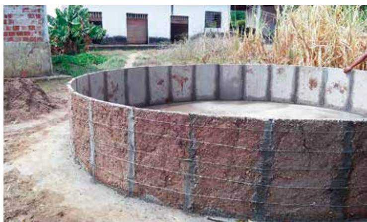
Figura 14. Tanque construído com placas.
