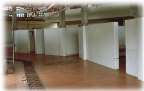
Instalaciones del Matadero Municipal
