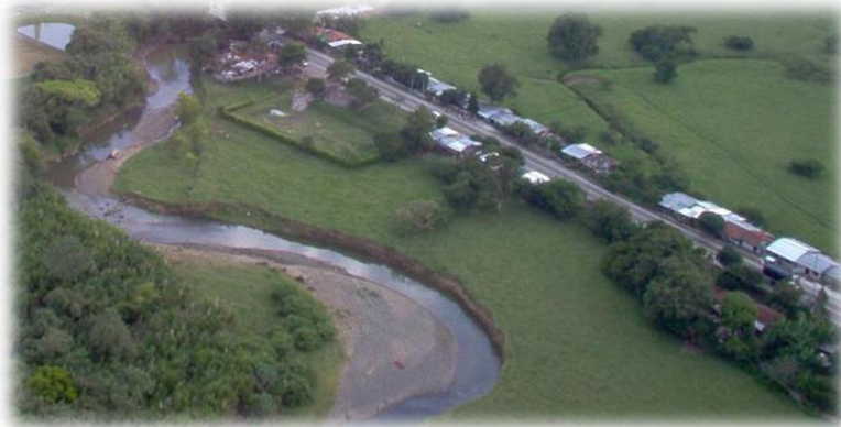
Rivera del río La Paila, problema de inundación y sedimento lecho del río
