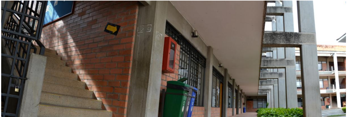
Imagen 2. Pasillo principal primer nivel Bloque Académico – INTEP
