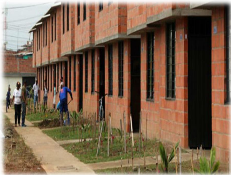
Figura 7-2. Casas del Barrio Potrero Grande. Fuente: Alcaldía Santiago de Cali.
