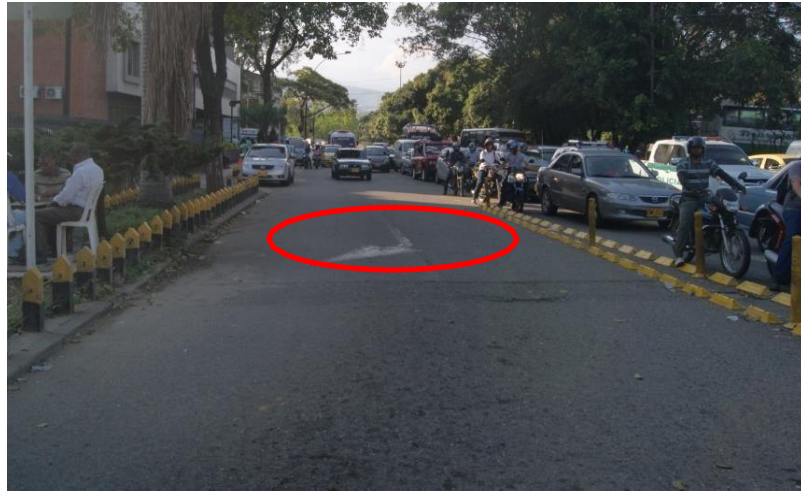
Figura 22. Señal de giro con geometría diferente al exigido por el manual de señalización de 2015
