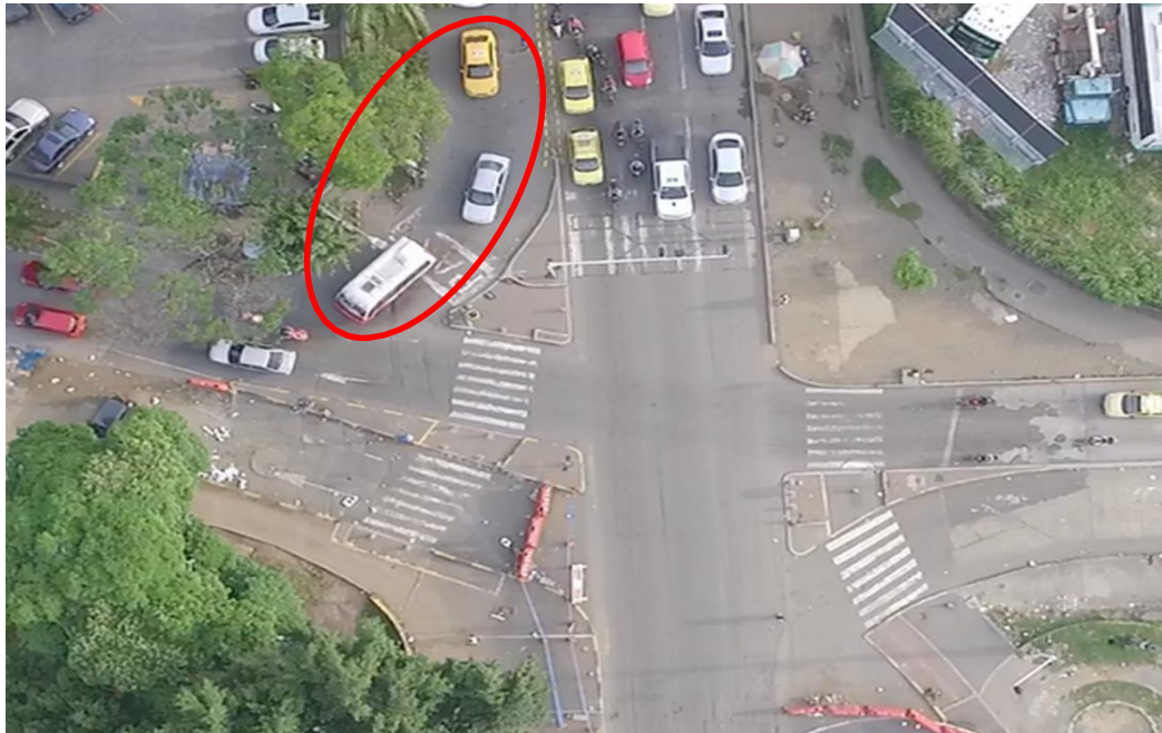
Figura 15. el giro a la derecha a través del enlace se hace a riesgo no hay carril de aceleración
