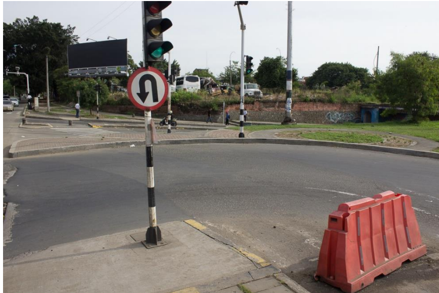
Figura 54. Vista hacia retorno a la izquierda ubicado en la calle 25
