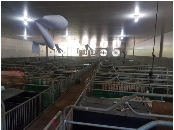
Anexo A- 3. Galera climatizada.
