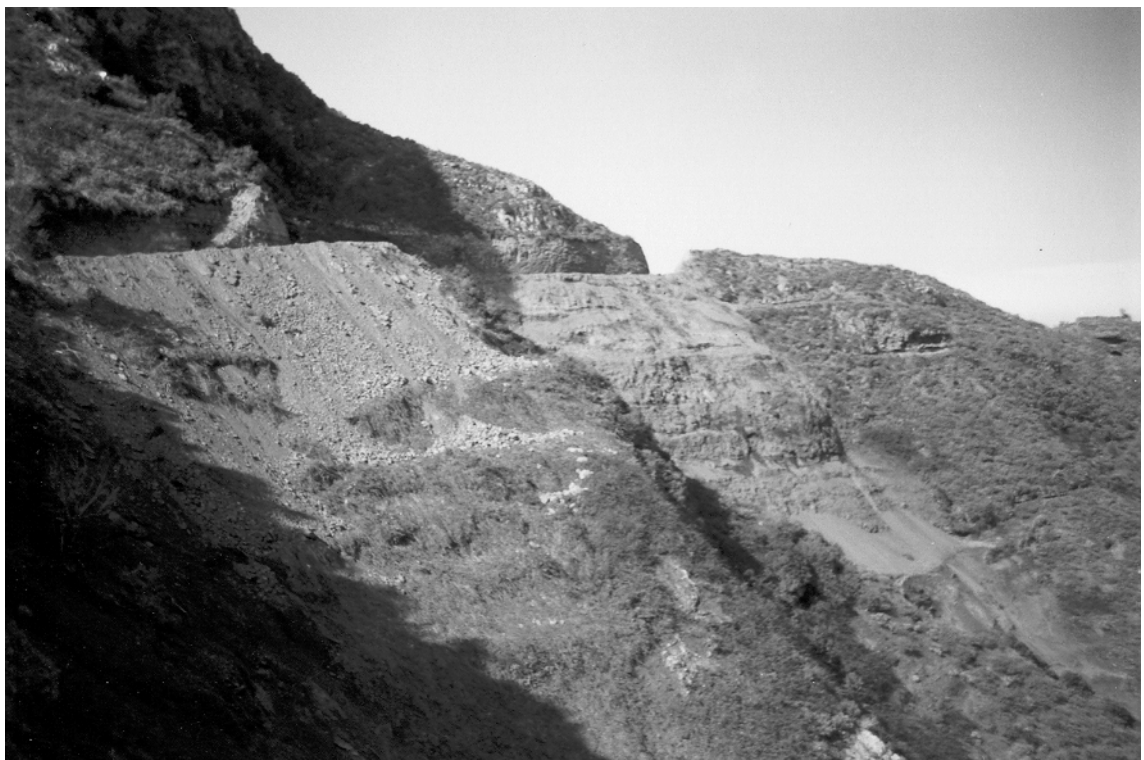
Abbildung 4.1: Massive Vegetationsschäden durch Schuttverlagerungen im Zuge der Bauarbeiten an der Straße zwischen „Las Carboneras“ und „Chinamada“ (Foto: W. Wildpret de la Torre, Ende der 1980er Jahre)
