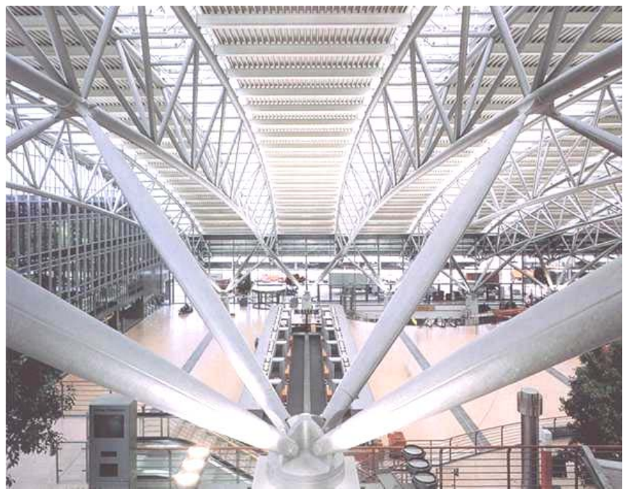
Abb. 5.12 a: Kontinuierlich gekrümmter Raumfachwerkträger [47]
