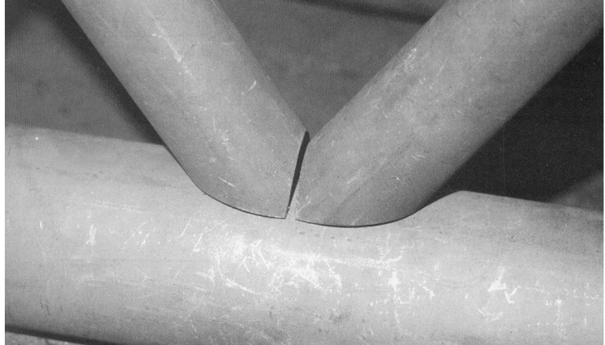
Abb. 7.21: Für die Schweissarbeiten vorbereitete Profillenden [60]
