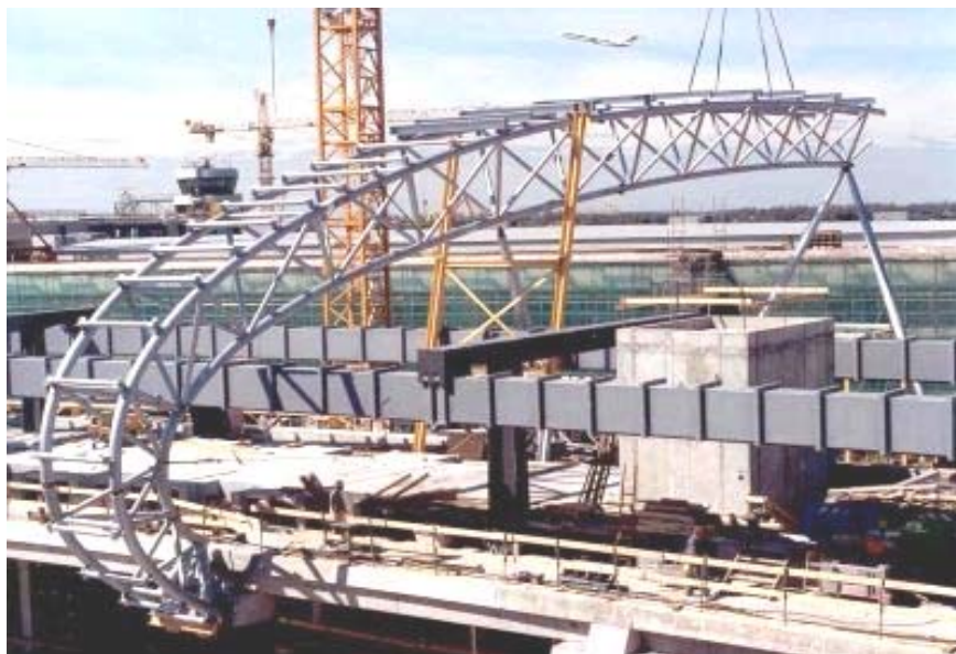
Abb. 6.26: Gekrümmter und räumlicher Fachwerkbinder [53]
