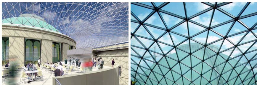
Abb. 6.18: Unregelmäßig gekrümmtes Dachtragwerk mit 4878 unterschiedlichen Stäben und 1566 unterschiedlichen Knoten [55], [56]
