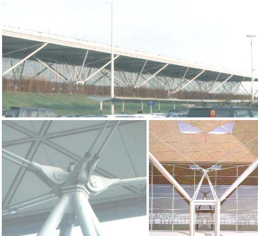
Abb. 7.19: Kombinationen mehrerer Verbindungstechniken [60], [55]
