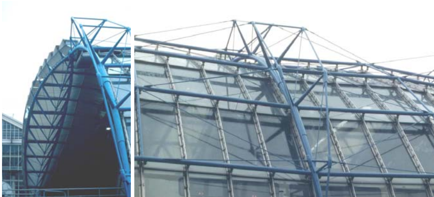
Abb. 5.12 b: Kontinuierlich gekrümmte Raumfachwerkträger [60], [59]
