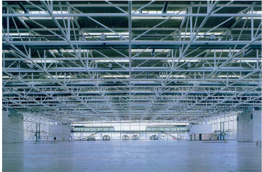
Abb. 6.22: Weit gespanntes, ebenes Raumfachwerk [41]
