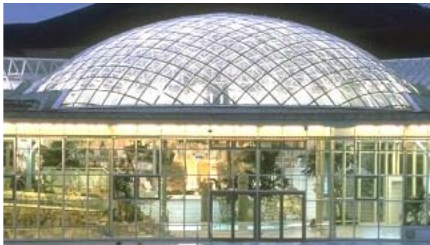
Abb. 6.15: Gekrümmtes Tragwerk mit Vierecknetz [66]
