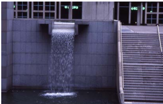
Abbildung 169: Wasserschleier im Parc de la Villette
