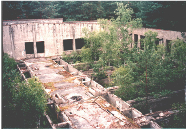
Foto 16: Ablagerbecken des Bober-Wasserwerkes. Foto: Martina Löbner, Juli 1996.
