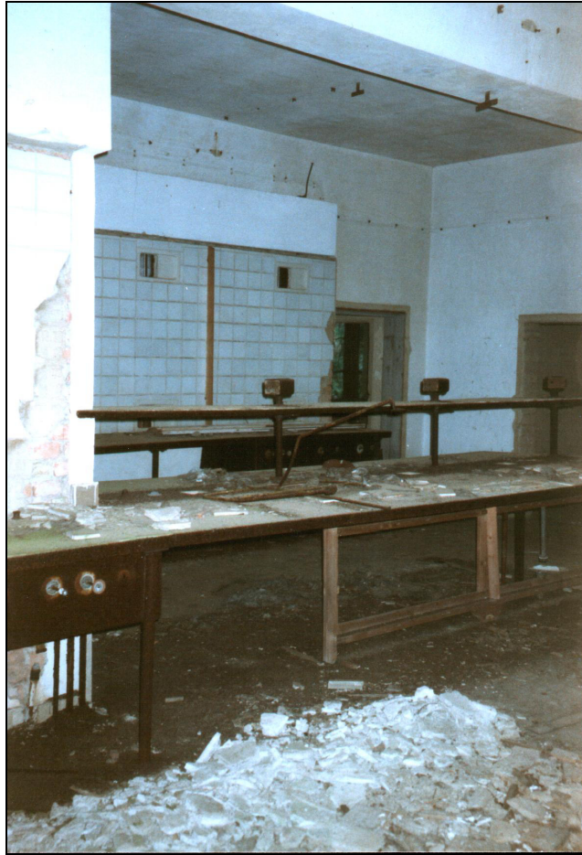
Foto 18: Clausthal-Zellerfeld, Sprengstoff-Fabrik Tanne , Labor. Foto: Martina Löbner, August 1999.
