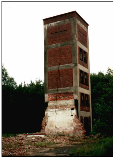
Foto 15: Turm der ehemaligen Werksfeuerwehr. Foto: Martina Löbner, August 1997.
