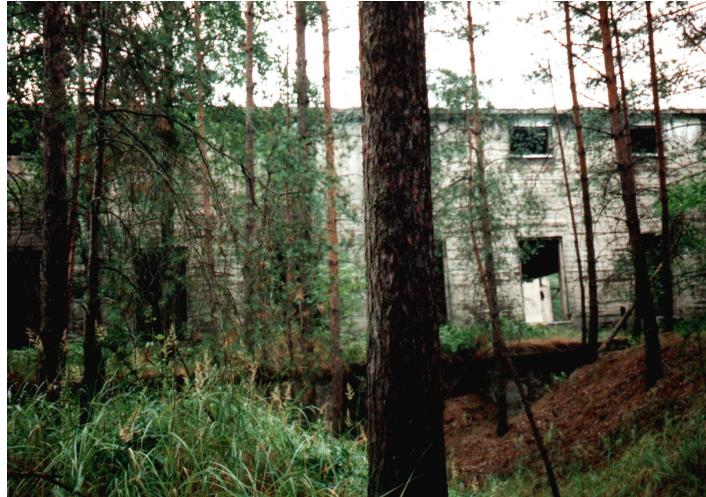
Foto 13: Getarntes Fabrikgebäude in Skelettbauweise. Foto: Martina Löbner, August 1997.
