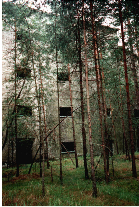
Foto 12: Getarntes Fabrikgebäude in Skelettbauweise. Foto: Martina Löbner, August 1997.
