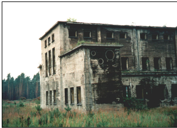
Foto 14: Produktionsgebäude der Säurefabrik. Foto: Martina Löbner, August 1997.
