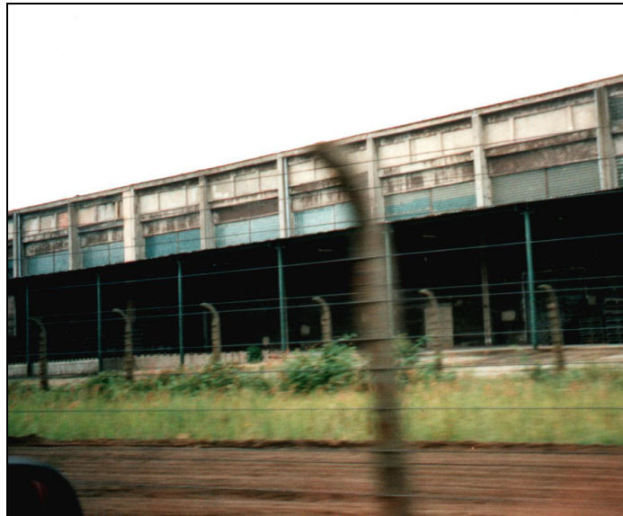
Foto 11: Versandgebäude der Sprengstoff-Fabrik. Im Vordergrund ist der „geharkte Sicherheitsstreifen“ mit Sicherheitszaun erkennbar, der bis heute den Kernbereich des Fabrikgeländes umgibt. Foto: Martina Löbner, August 1997.
