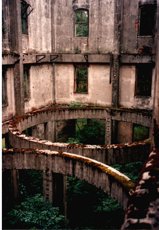
Foto 17: Hauptpumpwerk des Bober-Wasserwerkes nach der Demontage.
