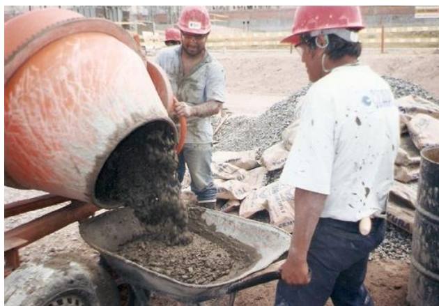
Figura 22. Operador del equipo.
