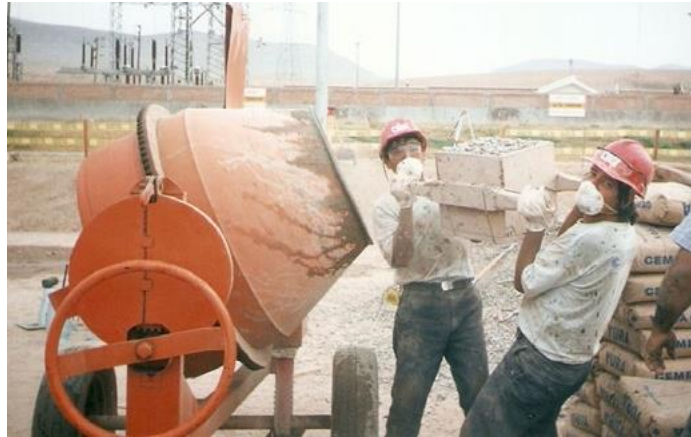
Figura 23. Operarios dosificadores de agregados y cemento
