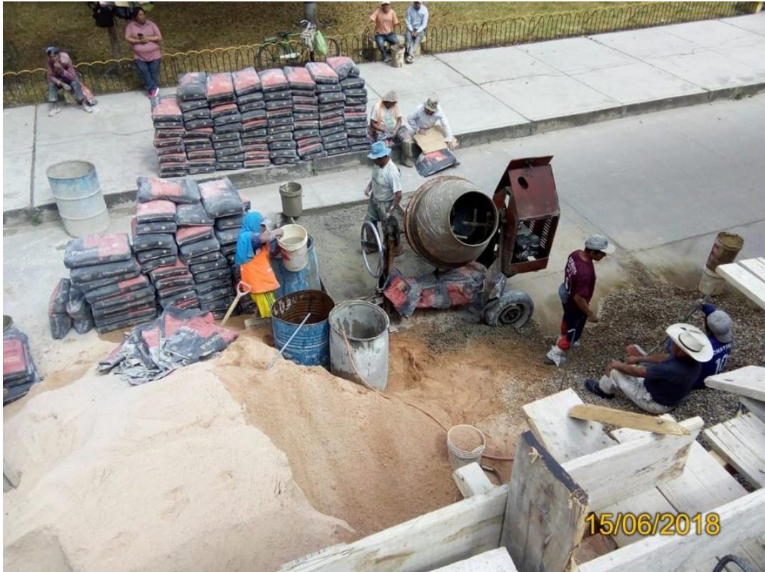
Fotografía 3. Control de la cantidad de agua en losa aligerada N° 10 en Jr. Mariano Ibérico N° 321 - Cajamarca.
