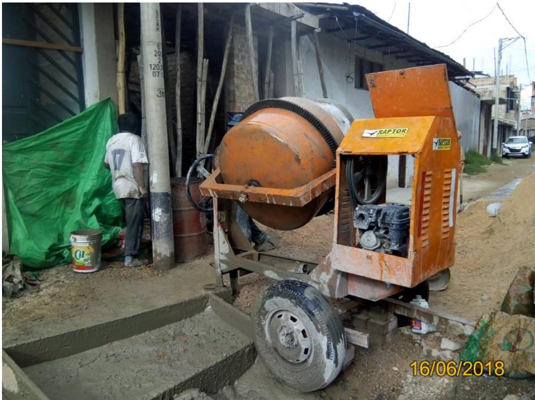
Fotografía 2. Mezcladora de concreto tipo trompo utilizado en la preparación del concreto Psje. Los Cartuchos S/N – Cajamarca.
