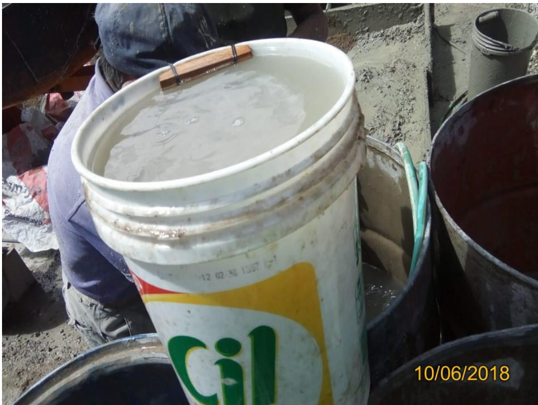
Fotografía 6. Lata (balde plástico) con la cantidad de agua utilizada para la preparación de una tanda en Jr. Los Ángeles – Cajamarca.
