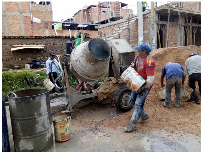
Figura 20. Carguío de materiales a la mezcladora.
