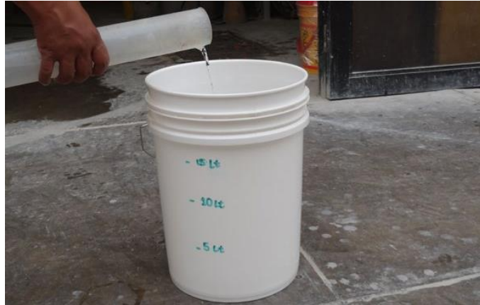
Figura 18. Dosificación de agua mediante probeta.
