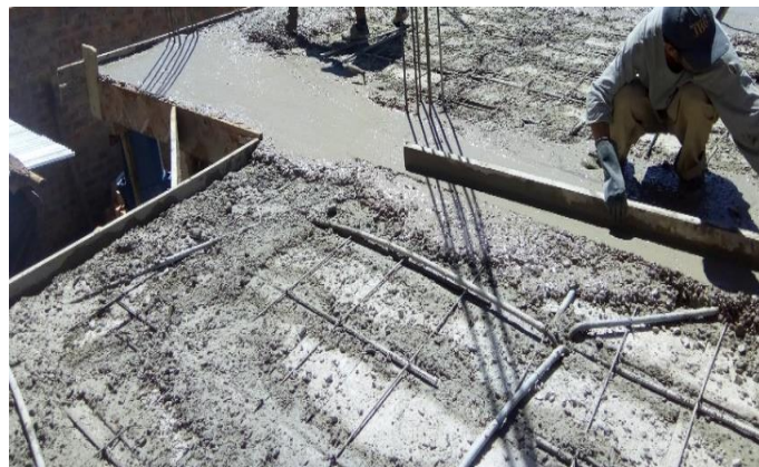
Figura 24. Vaciado de concreto en losa aligerada - Cajamarca
