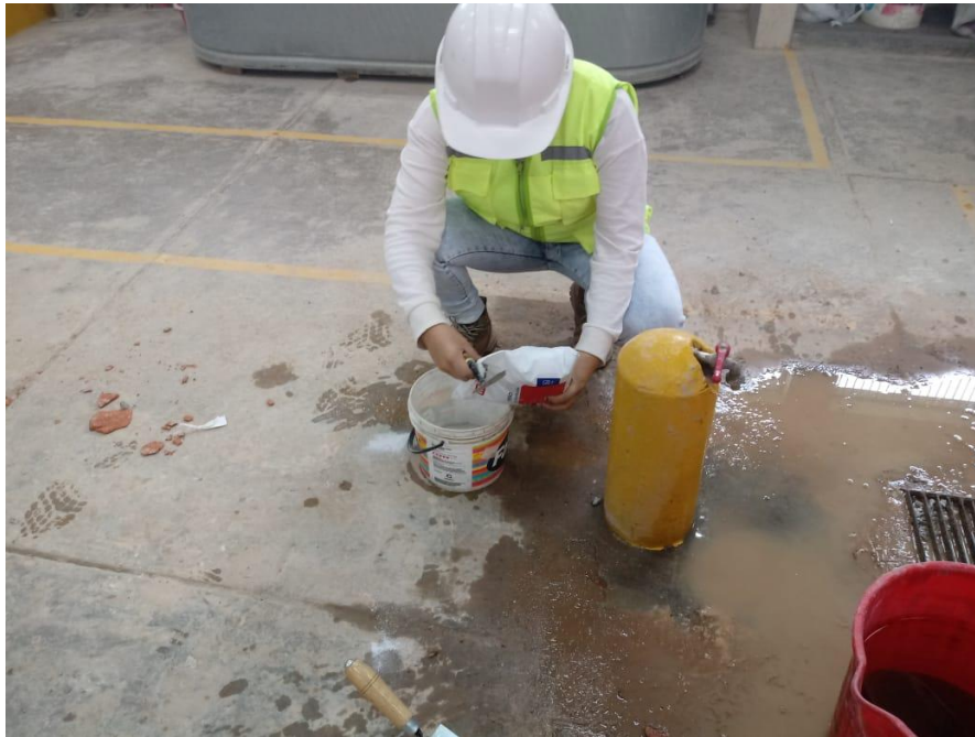
Fotografía 5: Preparación de material para refrentado
