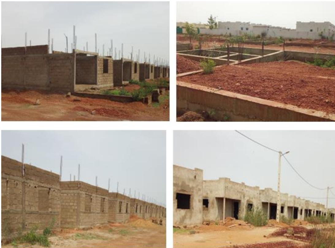
*Figure 5.3: Vue de loin des différentes étapes de construction des logements sociaux type F3B de la cité de N'Tabacoro*
