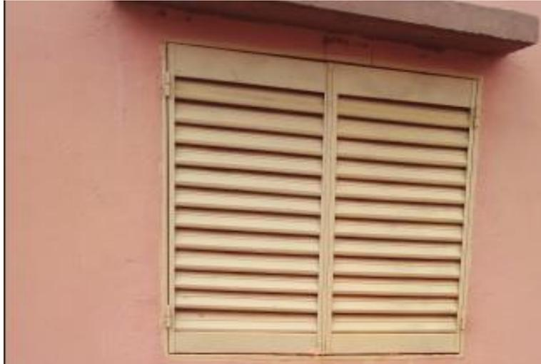
*Figure 4.19: Illustration de la fenêtre en persienne métallique du bâtiment test*
