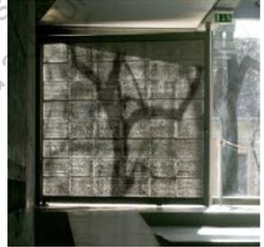
*Paroi en blocs de béton translucide, Litracon*
