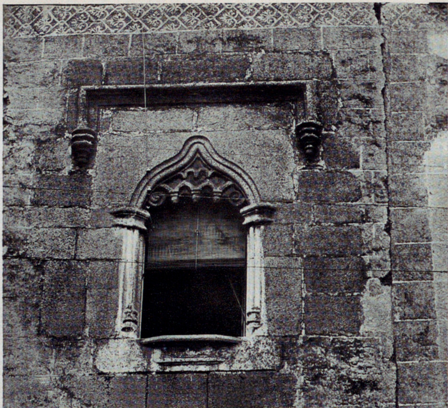
BELLA VENTANA GÓTICA EN LA CASA DEL ÁGUILA.
