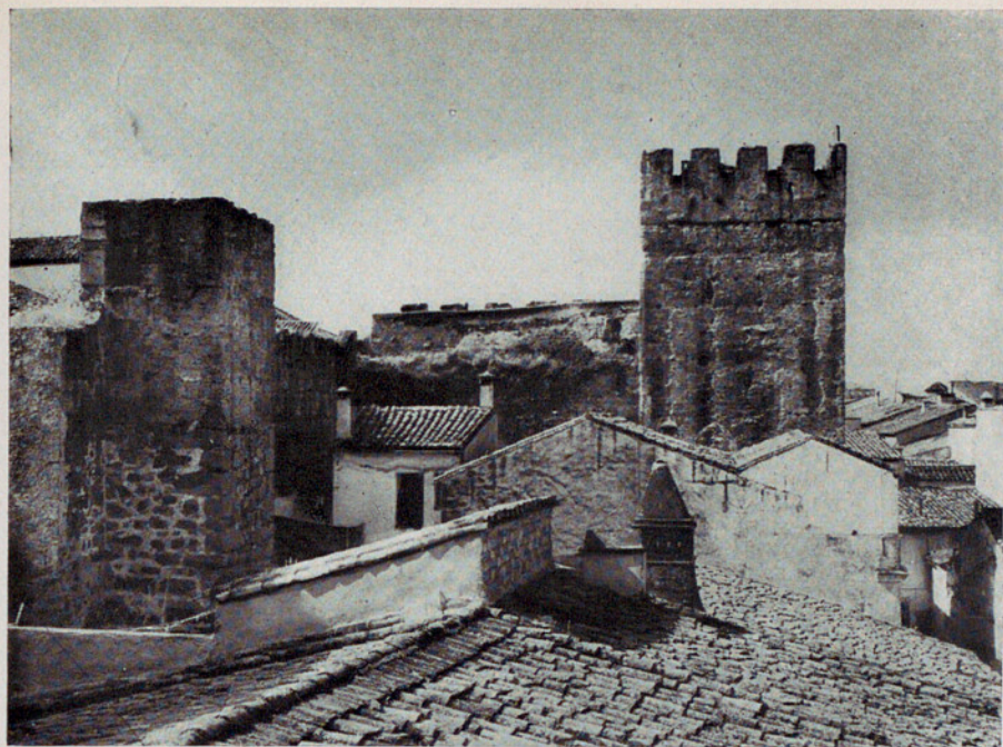
TORRE DEL POSTIGO CON LOS REDUCTOS CERCANOS.
