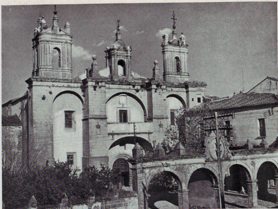
ATRIO Y FACHADA BARROCA DEL CONVENTO DE SAN FRANCISCO.
