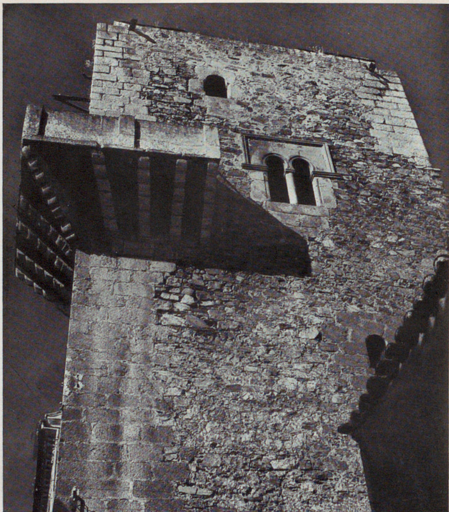
LA SOBRECOGEDORA TORRE DE ESPADEROS, VISTA DESDE SU PIE.
