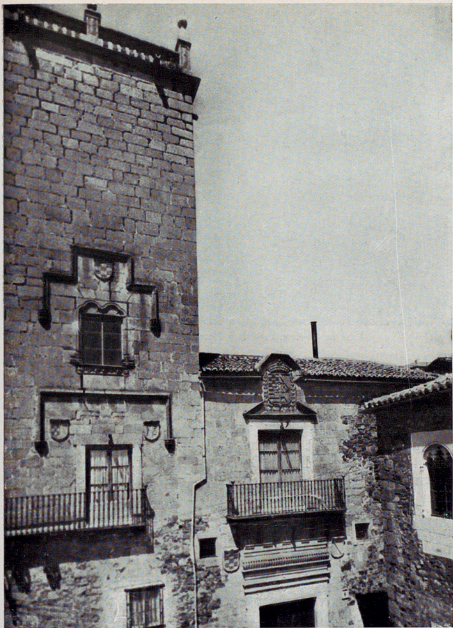
FACHADA Y TORRE DEL COMENDADOR.
