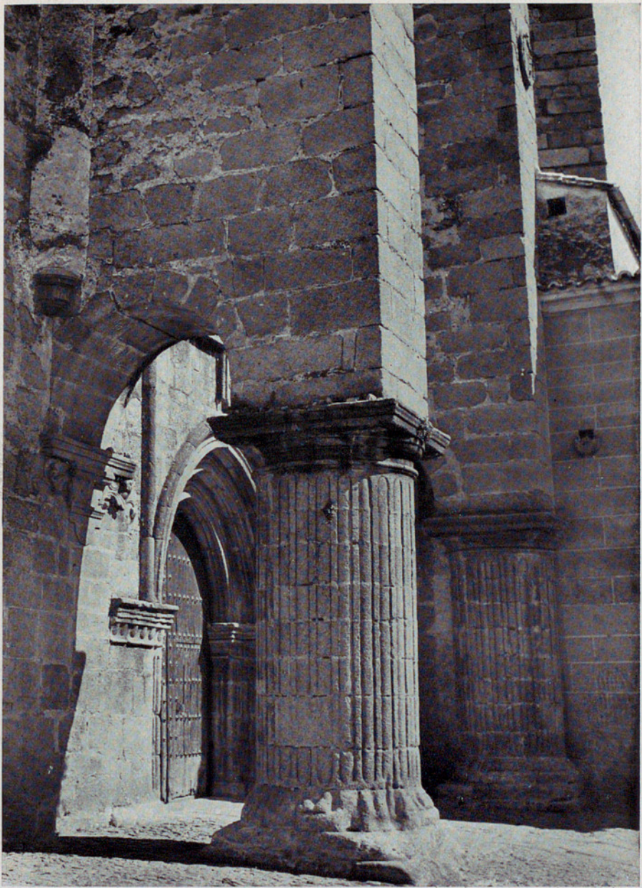
SANTIAGO: DETALLE DE LA FACHADA SUDESTE.
