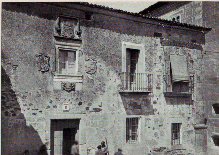
CASA DE DURÁN DE LA ROCHA, EN EL RINCÓN DE LA MONJA.
