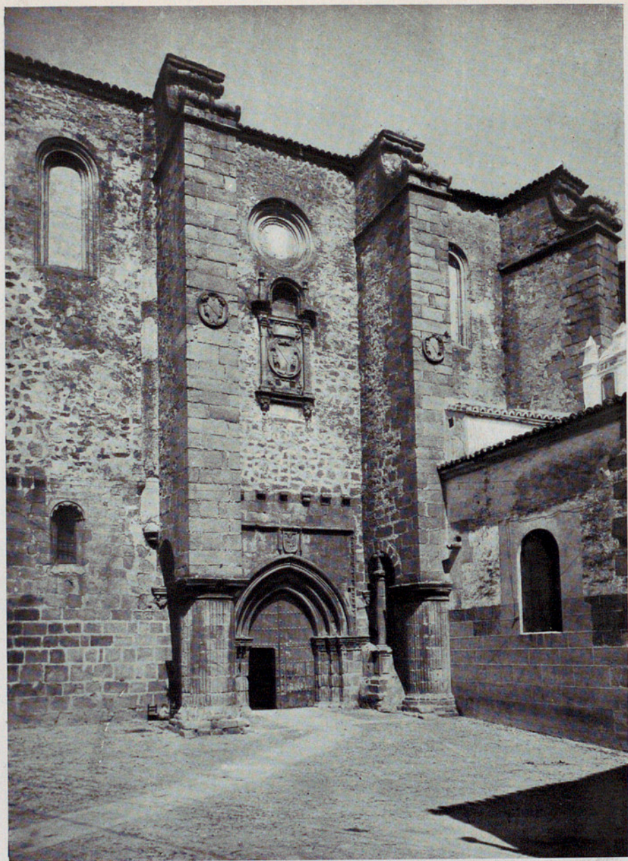
IGLESIA DE SANTIAGO: FACHADA SUDESTE.
