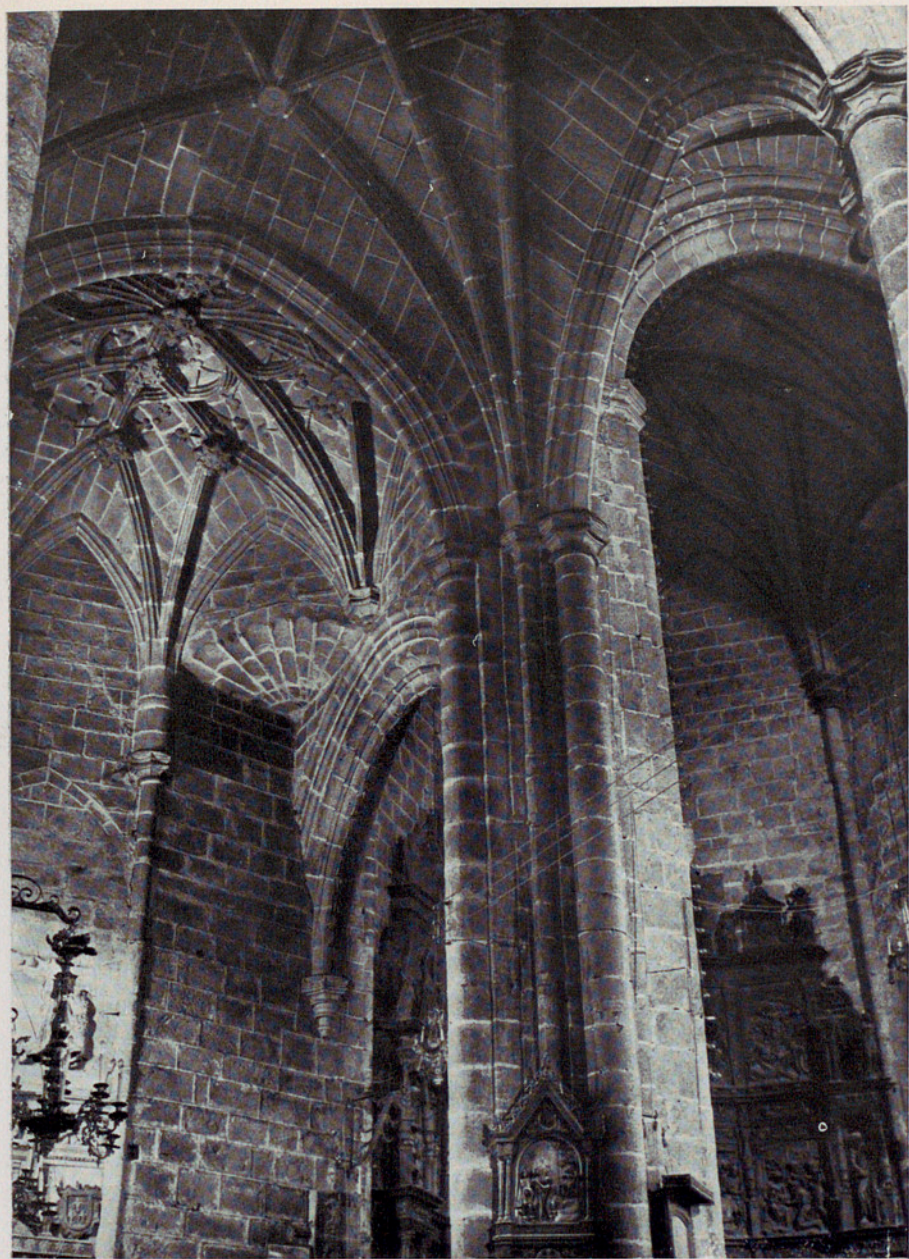
SANTA MARÍA. DETALLE DE LAS CRUCERÍAS GÓTICAS.
