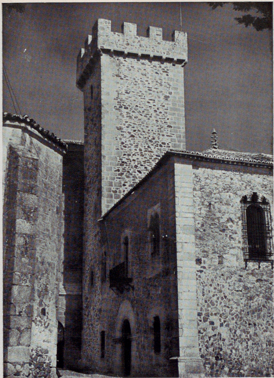
TORRE Y PALACIO DE LAS CIGÜEÑAS.
