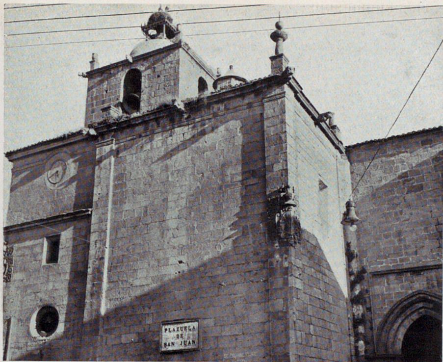
IGLESIA DE SAN JUAN. FACHADA ANTERIOR.
