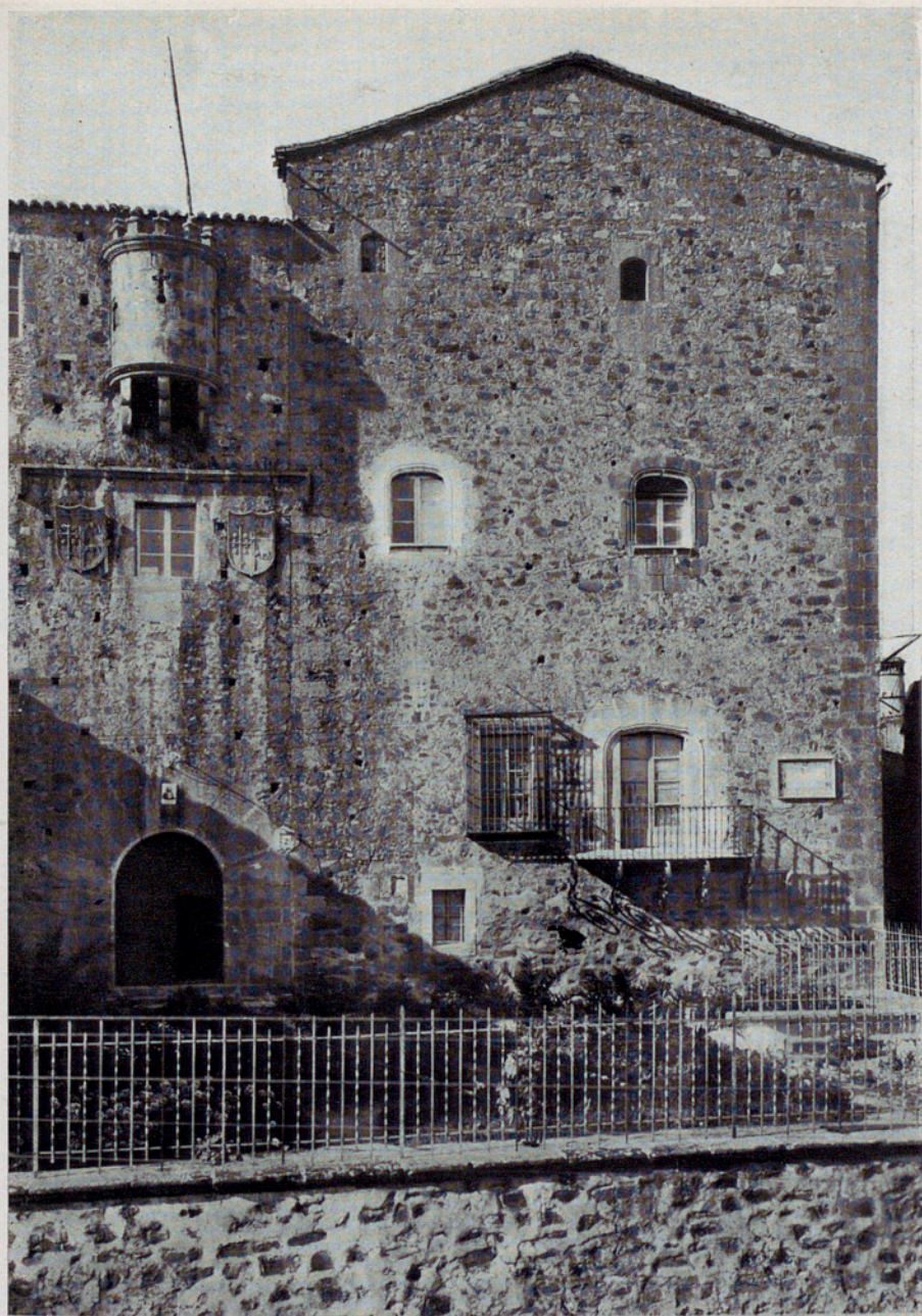
FACHADA DE LA CASA DE LA GENERALA.
