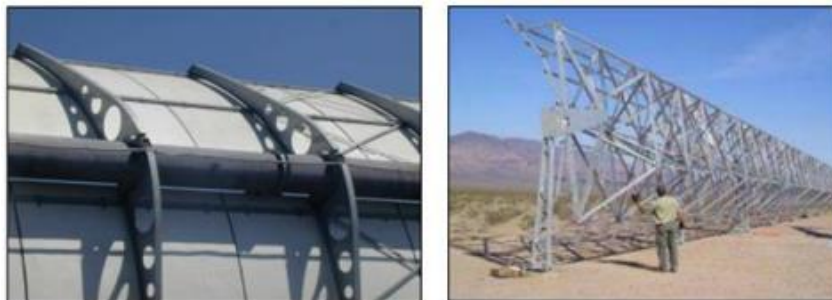
Figura 14: Estructura de los colectores
