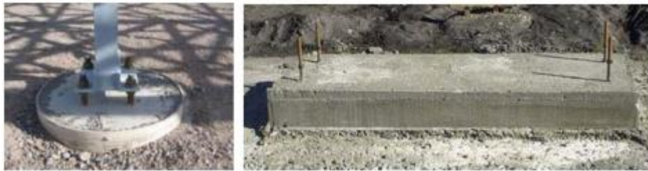
Figura 13: Pilotes de los colectores
