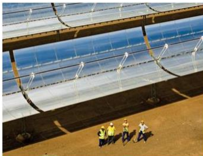
Figura 12: Colectores de la central
