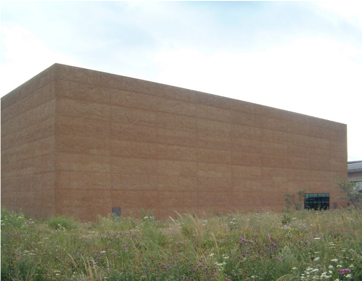
3 Schaulager (Emanuel Hoffmann-Stiftung), Basel/Münchenstein, Switzerland, 2003. Rear view. Architect: Herzog & de Meuron.
