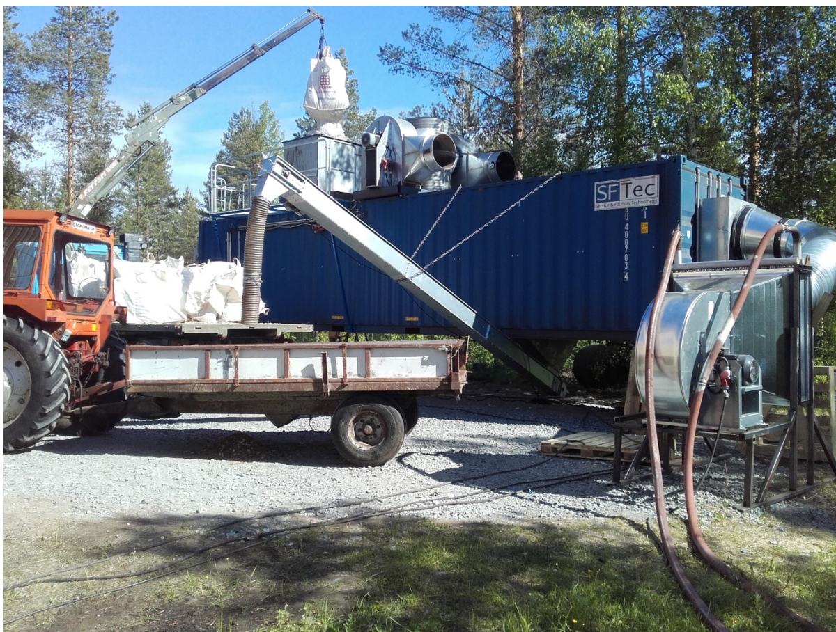
Kuva 10. Kuivauksessa hyödynnettiin lämpölaitoksen reservilämpöä. Lämpölaitoksen vesikierto ohjattiin erilliselle lämmönvaihtimelle (kuvassa oikealla), josta lämmin ilma puhallettiin edelleen kuivuriin.
