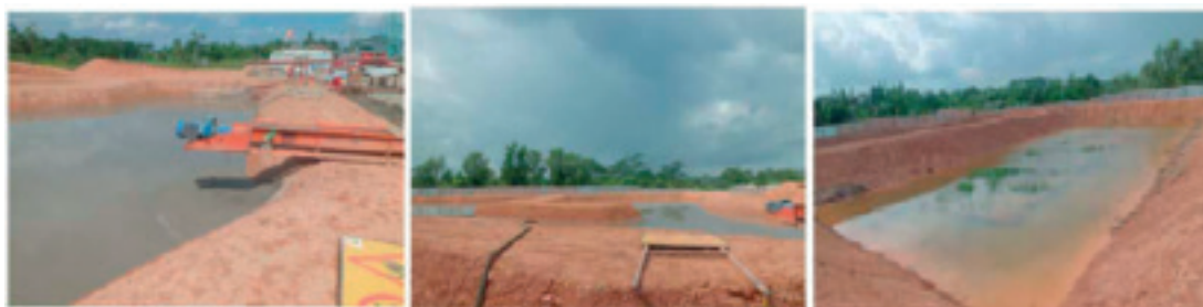
Slika 8: Prikaz jame s tekućom fazom isplake od početne (lijevo) do završne faze (desno) „online“ bioremedijacije (Lesto & Kasumo, 2015)
