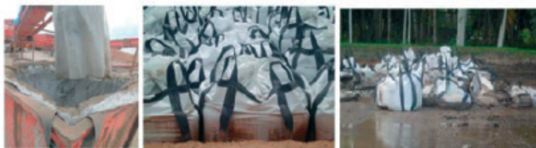
Slika 7. Odlaganje obrađenog krutog otpada u vreće u kojima se nastavlja bioremedijacija (Lesto & Kasumo, 2015)
