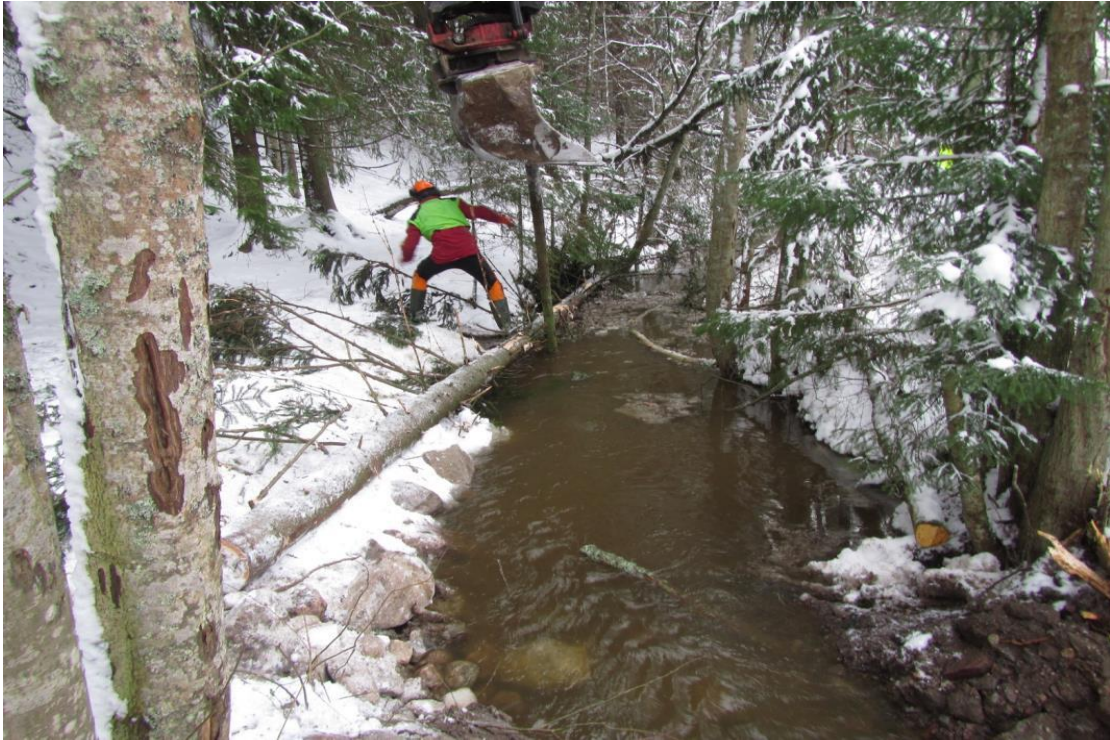
Kuva 9. Puunrungot kiilattiin uoman ulkokurveihin ja kiinnitettiin uoman pohjaan upotetuilla puutolpilla. Kuva Turo Hjerpe.
