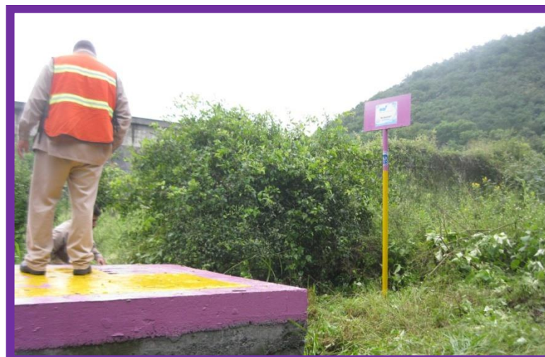
Figura 4. 37 Pintura y señalización de trazo de SAART P'tar Santiago-Cárcamo Huajuco.
