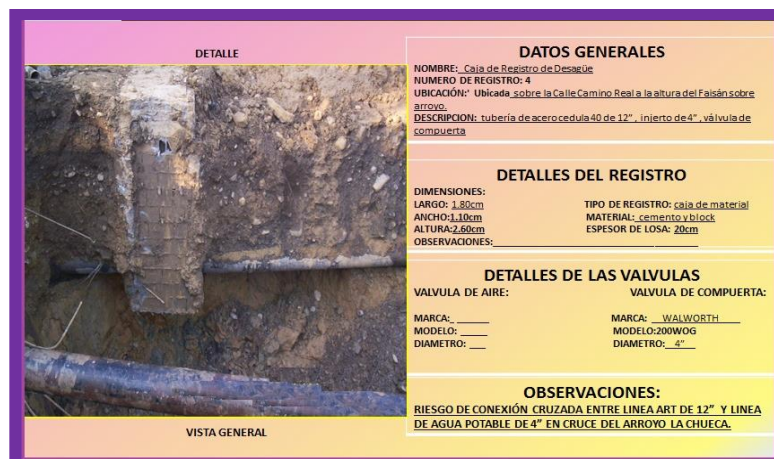
Figura 4. 32 Tuberías de agua potable y agua residual tratada no identificadas.
