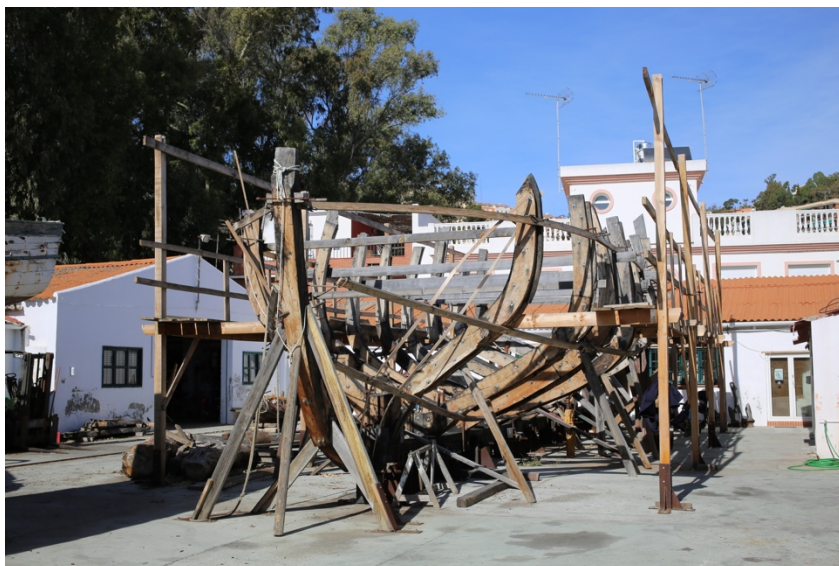
Figura 33. Construcció de la rèplica del bergantí Galveztown . Font: pròpia
