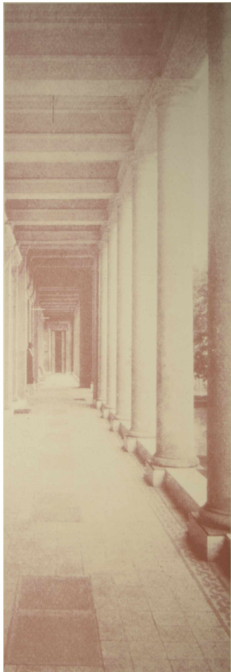
Departamento de Física (galería exterior)
