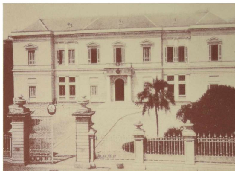
Edificio de la Universidad visto desde calle 6, antigua residencia de la Facultad de Humanidades y Ciencias de la Educación y de la de Ciencias Jurídicas y Sociales. Actualmente en la planta baja funciona el Liceo Víctor Mercante.
