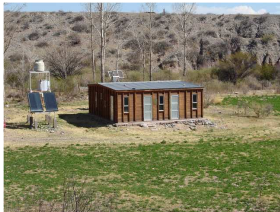
Figura 1. Refugio de la UNSa en Payogasta visto desde el Norte
