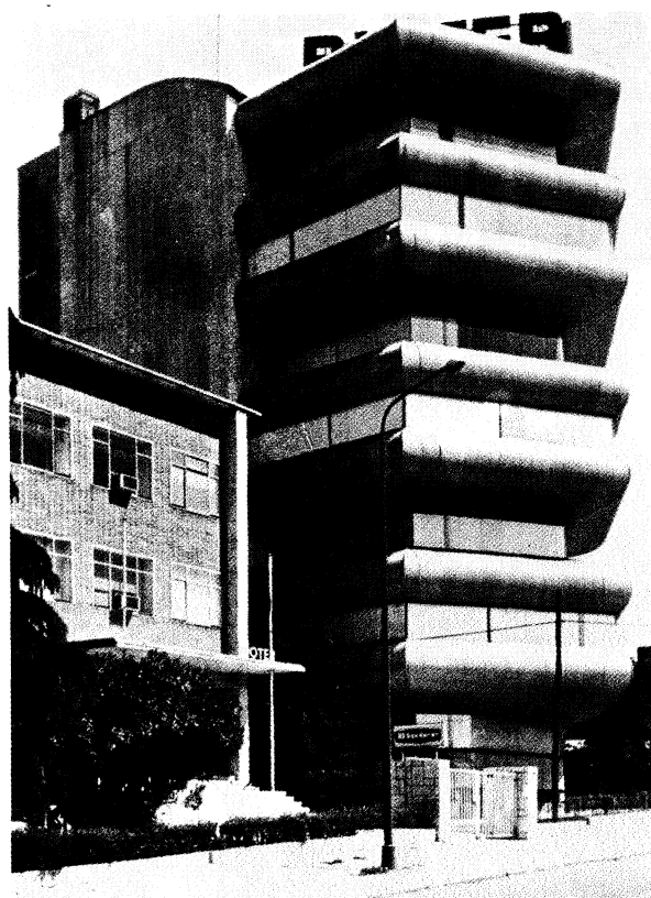
M. Fisac.—Edificio de oficinas en Madrid (Informes n.º 285).
