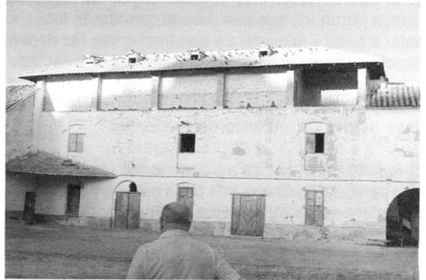
Una característica de los edificios rurales en su reutilización. Este granero de final del siglo XIX se recreció para usarse como secadero y posteriormente se cerró para su uso como palomar.
