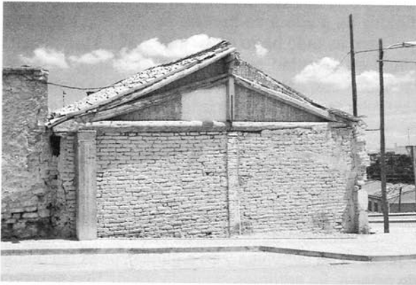
La edificación rural popular hace uso de todos los elementos constructivos disponibles en cada época.
