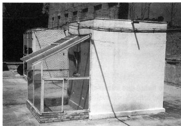
Foto 5.—Caseta con acumulación térmica adosada a la fachada Este.
