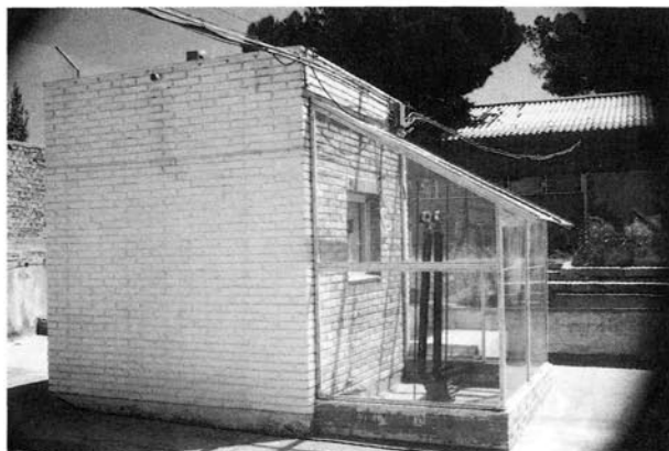
Foto 6.—Caseta con acumulación térmica, donde puede apreciarse el sistema del aire caliente al acumulador.
