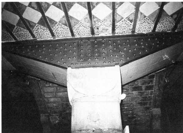
Fig. 10.—Detalle de un pilar y una jácena en la planta baja (1982).
