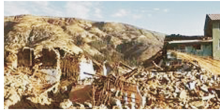
5. Casas de adobe destruidas por los sismos de Huaraz, 1970 (Fuente: NISEE) y de Pisco, 2007
