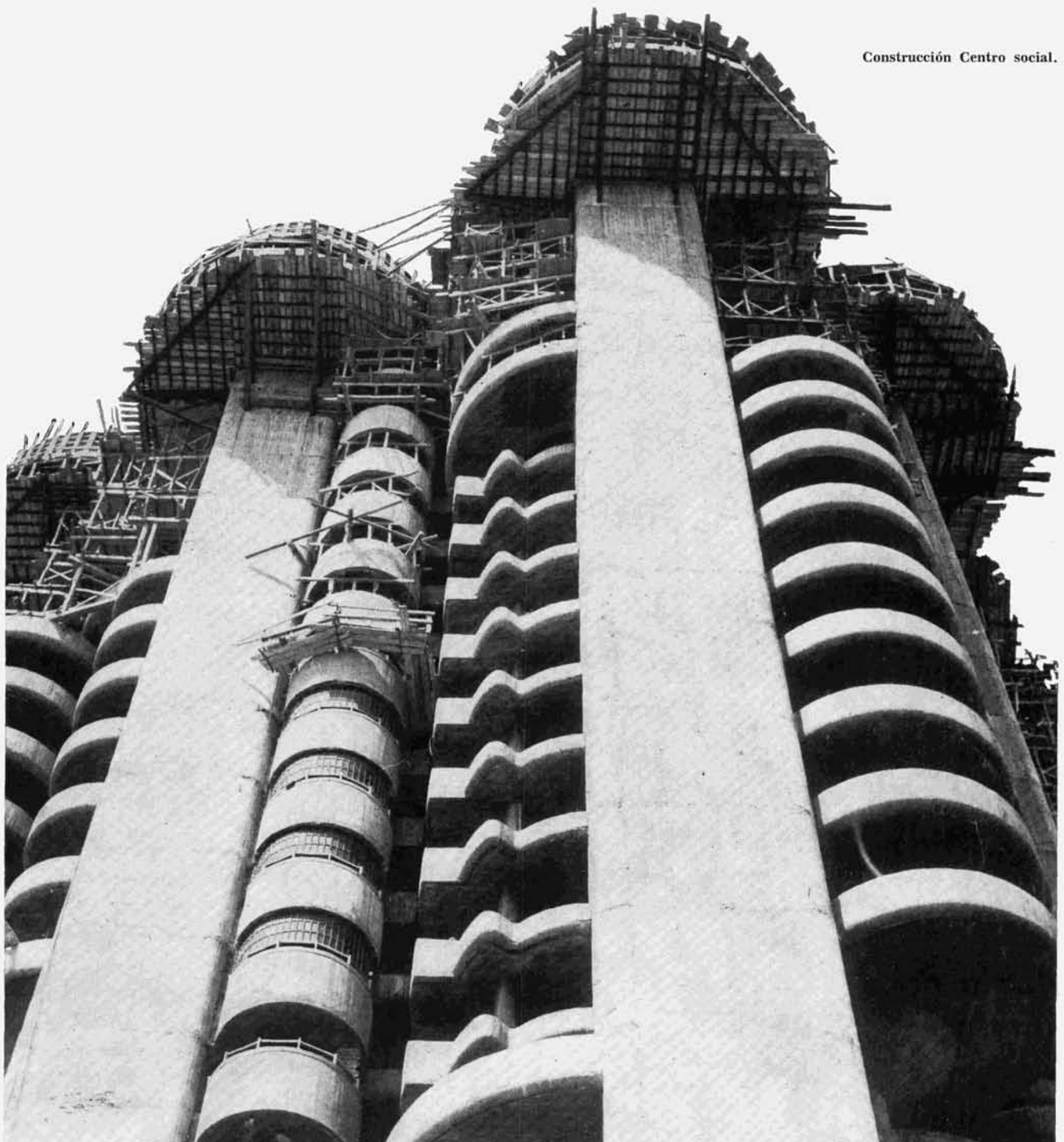
Armadura ascensores y escalera.
