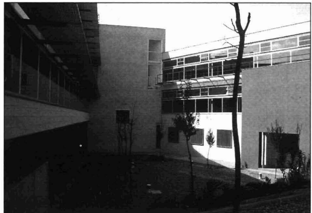
Vista general del espacio ajardinado interior.
