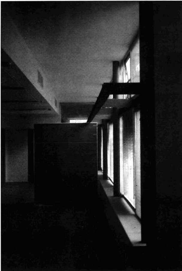
Detalle de separación de Esperas.
