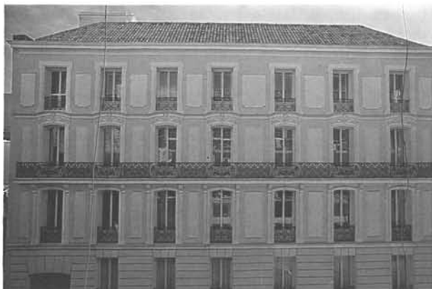
El edificio vuelto a construir, calle San Marcos
