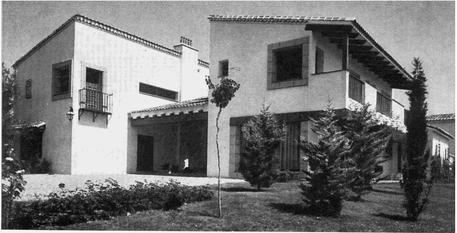
Fachada S.: Entrada principal.
