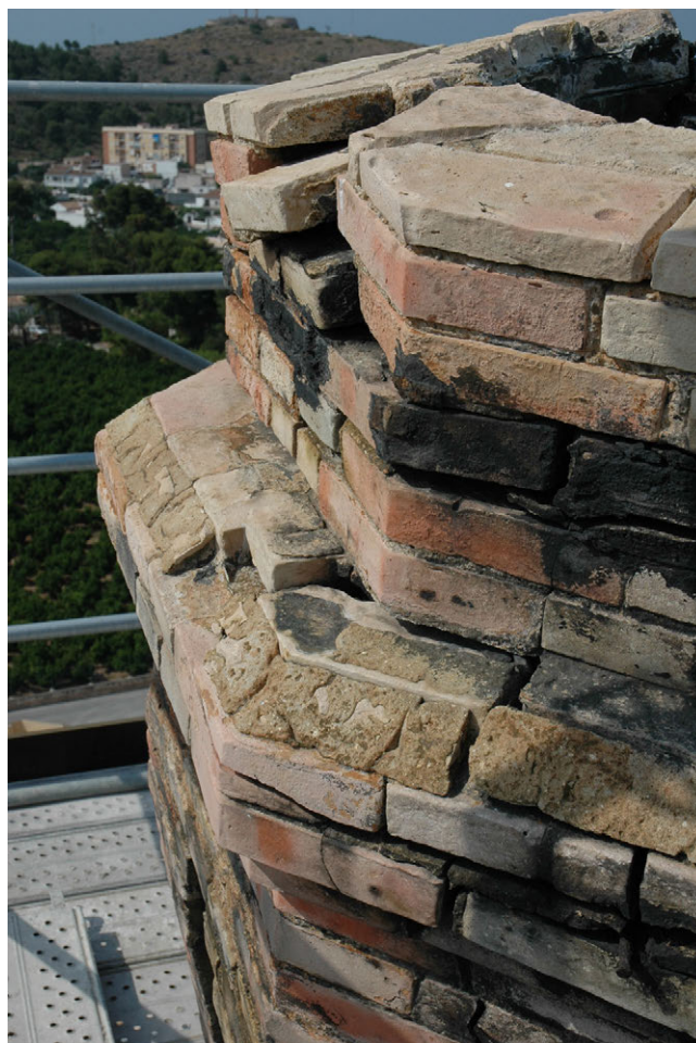
Figura 12. Corona de chimenea con bordón y boquilla.
