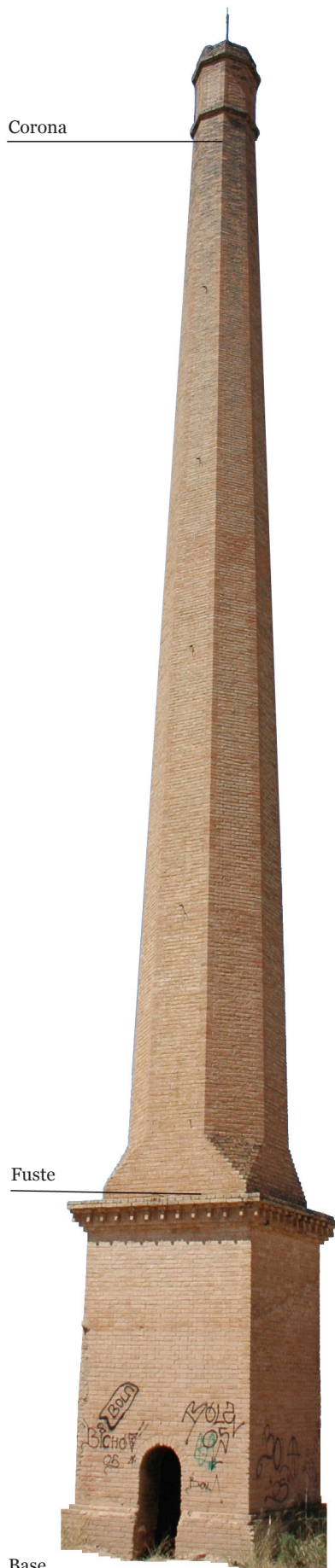
Figura 1. Chimenea de Casinos (Valencia).
