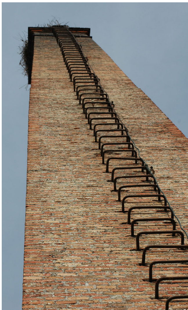
Figura 11. Anillas exteriores en forma de [ de la chimenea Electro Harinera Panificadora. Almodóvar del Campo (Ciudad Real).
