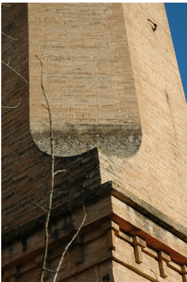
Figura 5. Pechina curvada. Chimenea fábrica del hielo L' Eliana (Valencia).
