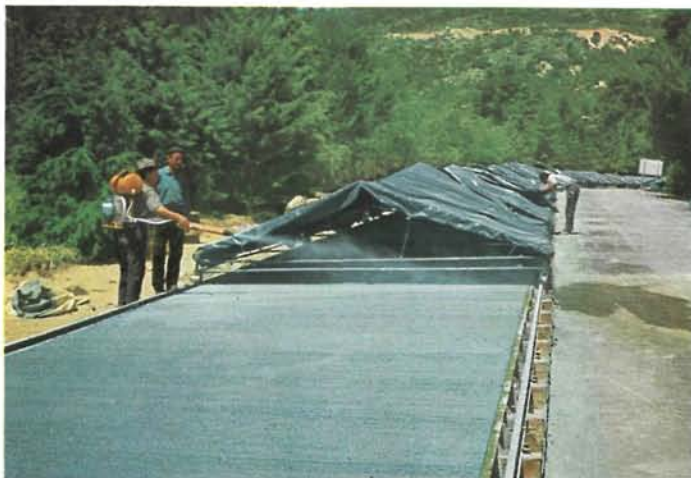
Fig. 22. Reparto del producto de curado y tren de tejadillos.
