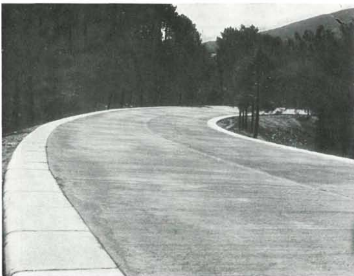
Figs. 10 y 11. Bordillos y cunetas, prefabricados en cemento blanco.
