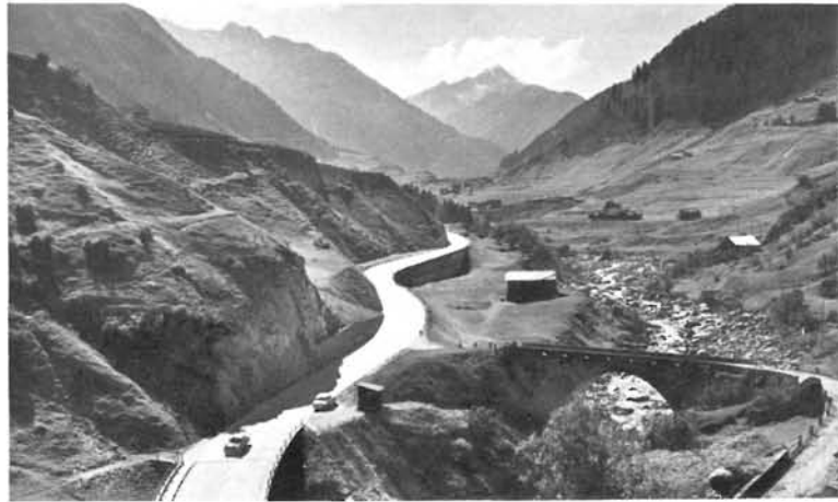
Fig. 3. Carretera de montaña en la zona de Curaglia (Suiza).
