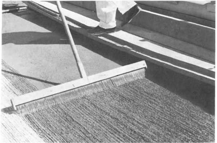
Fig. 7. Estriado de profundidad media, con cepillo de P.V.C.
