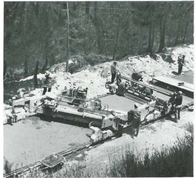
Fig. 21. Terminadora diagonal y cuchillo vibrante.
