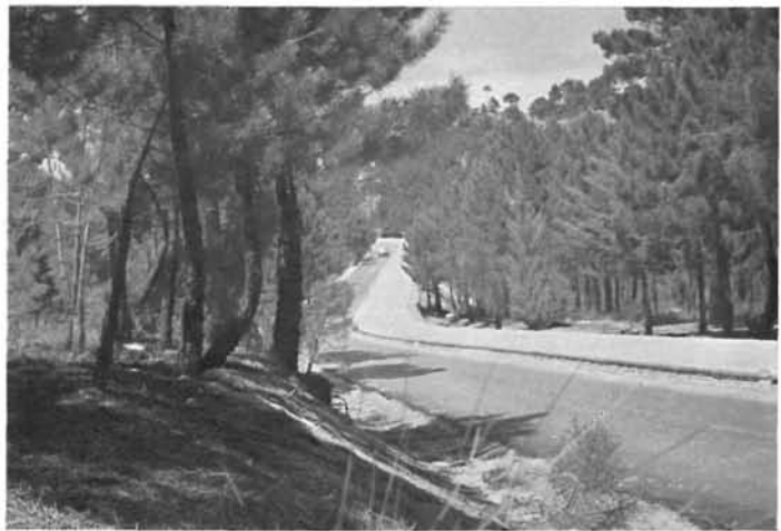
Fig. 8. Vista general, con media calzada hormigonada.
