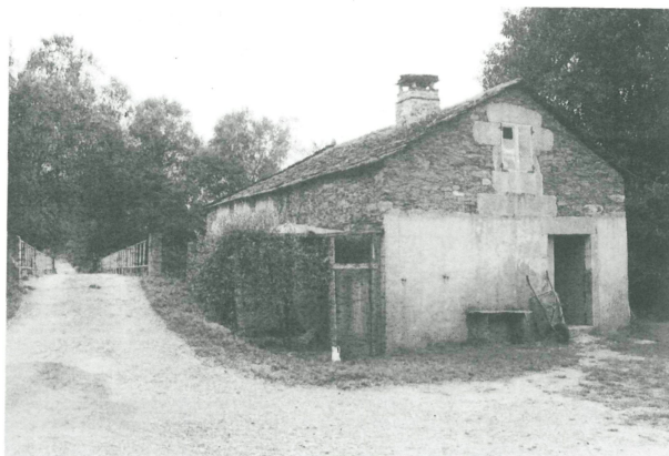
Muíño de Fontechousa. Actualmente, funcionando como molino. Molino con tres ruedas.
