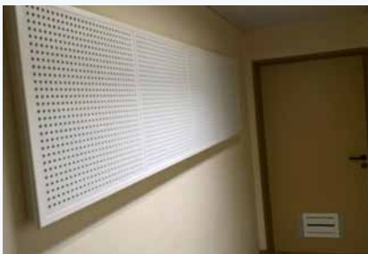
Figuur 3.20 Akoestisch ventilatierooster (DOX Acoustics) en absorberende wandpanelen (Gyproc) aan een bewonerskamer (Leiehome - Drogen).
