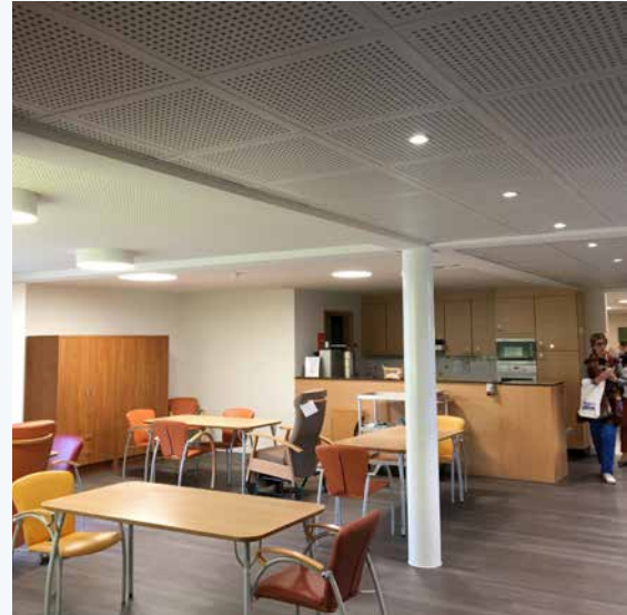
Figuur 3.24 Installatie van een zwevende vloer en absorberend plafond (Gyproc) in een leefruimte (Veilige Have - Aalter).
