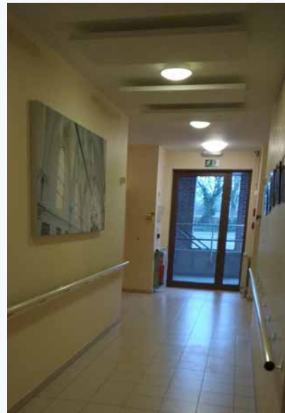
Figuur 3.21 Absorberende wand-en plafondpanelen (DOX Acoustics) in een gang (Sint-Jozef - Lier).
