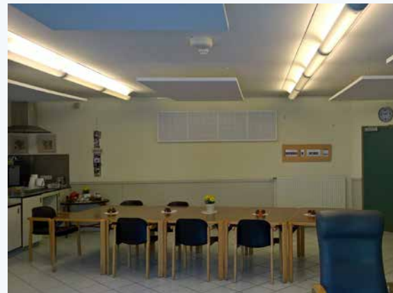
Figuur 3.25 Absorberende plafondpanelen (DOX-Acoustics) en wandpanelen (Gyproc) in een leefruimte (Leiehome - Drogenen).
