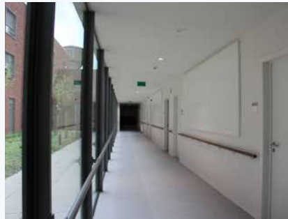
Figuur 3.22 Absorberende wandpanelen (Triplaco) in een gang (Sporenpark - Beringen).
