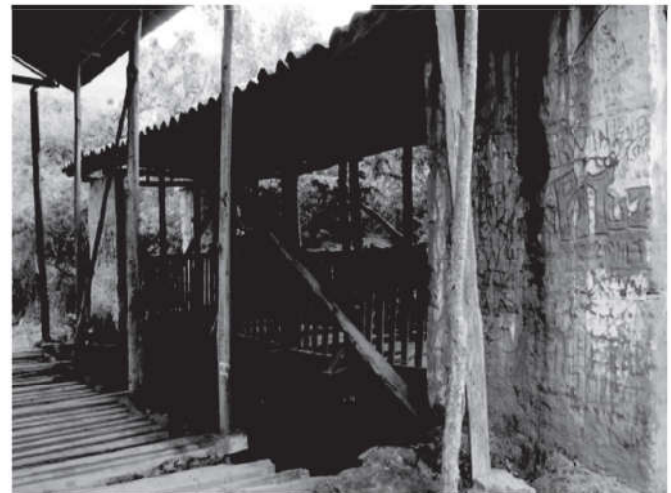
FOTO 18. Puente construido por Lengerke. FOTO. A. Toro
